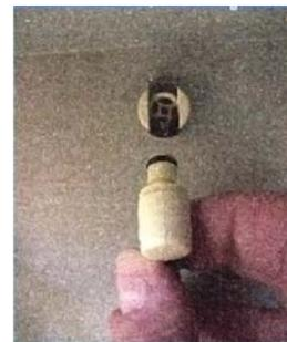
Druckluftschlauch im Serviceräum anschließen
